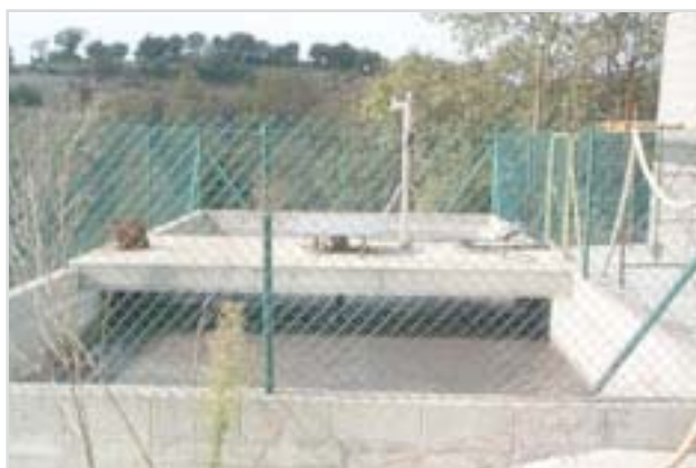
Figura 4.2. Balsa con agitación y dispositivo para aplicar aditivos
