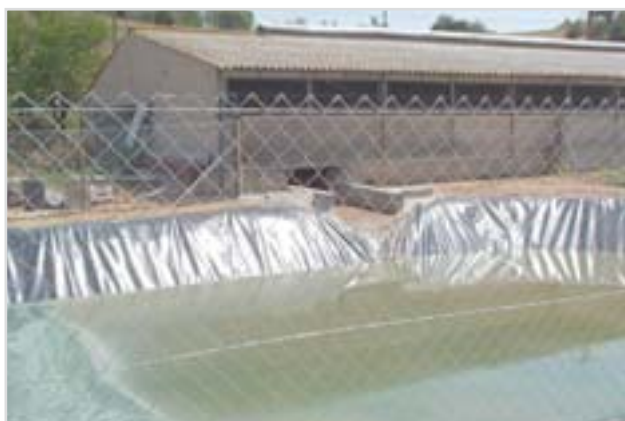
Figura 4.1. Balsa excavada con lámina de polietileno
