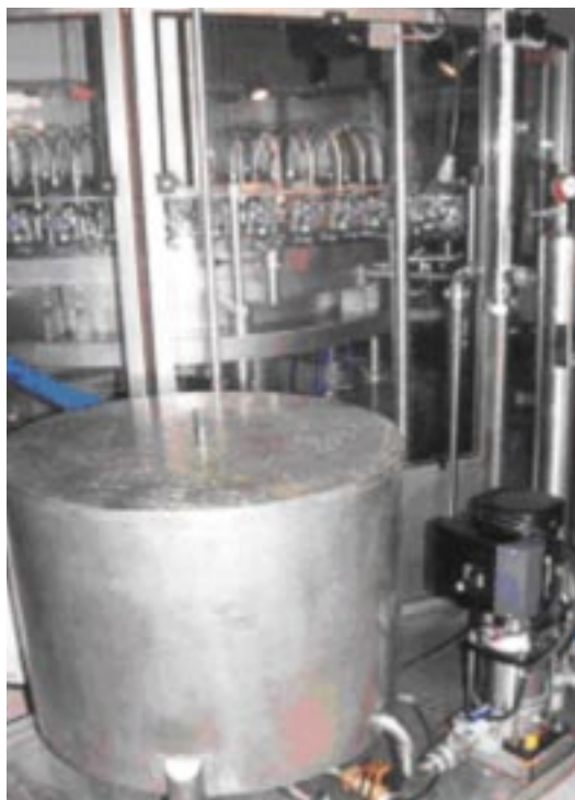
En primera línia dipòsit pulmó i tractament UV
