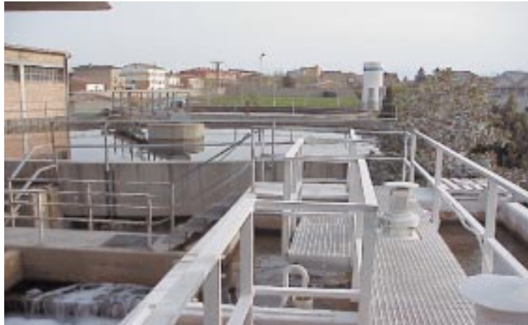
Decantador en primer terme i dipòsit d'oxigen al fons
