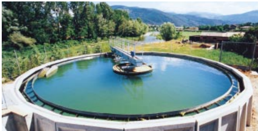
Decantador de fangs
